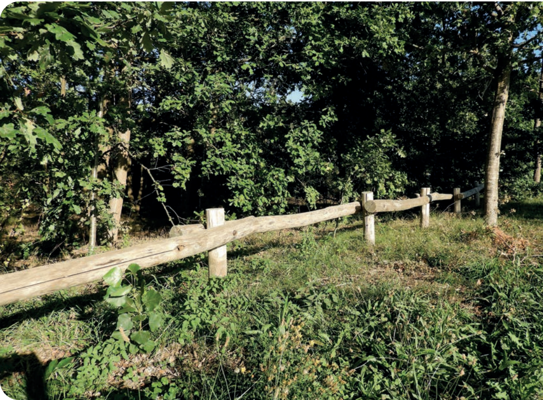
Tous les poteaux horizontaux sont bien finis et percés à l'avance.
